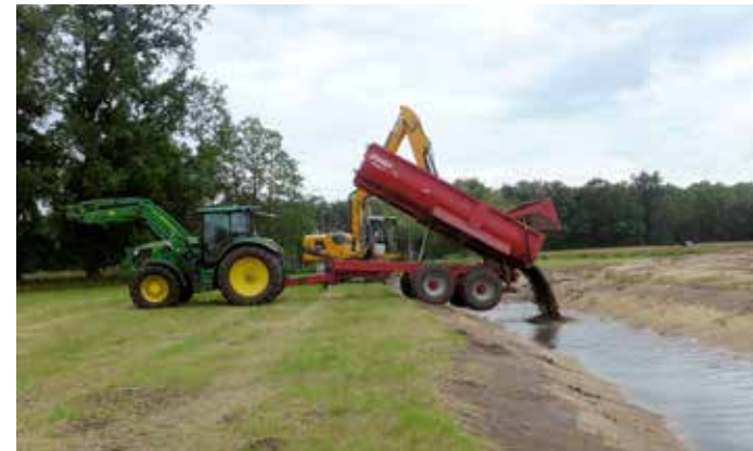
Abb. 4: Kies wird in das neugeschaffene Bachbett gekippt.
