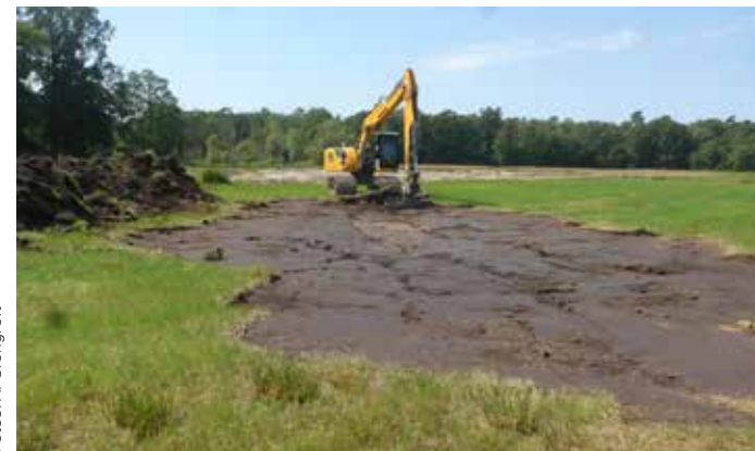
Abb. 6: Auf der AKN-Fläche wird eine Blänke angelegt.
