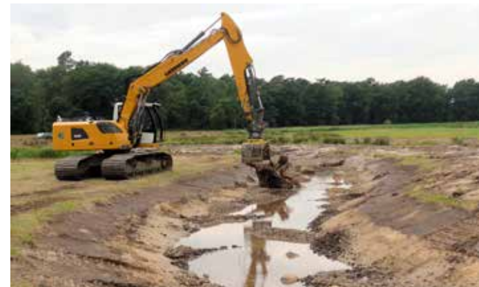
Abb. 5: Der Bagger setzt Baumstubben ein, der Kies ist zu Bänken und Bühnen verbaut.
