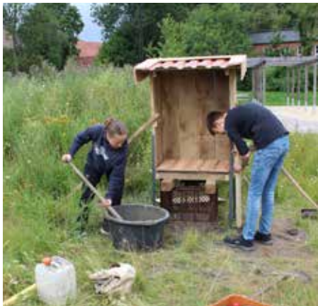
Abb. 3: Vier Säcke Betonestrich sorgen für den nötigen Halt (oben).
