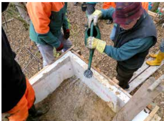
Das Lehm-Sandgemisch wird unter Zugabe von Wasser verdichtet
