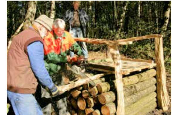
Die ersten Etappen sind erfolgreich bewältigt: das Fundament für die Brutkiste ist errichtet
