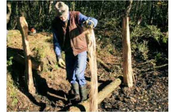
Die Eichenpfähle sind gesetzt
