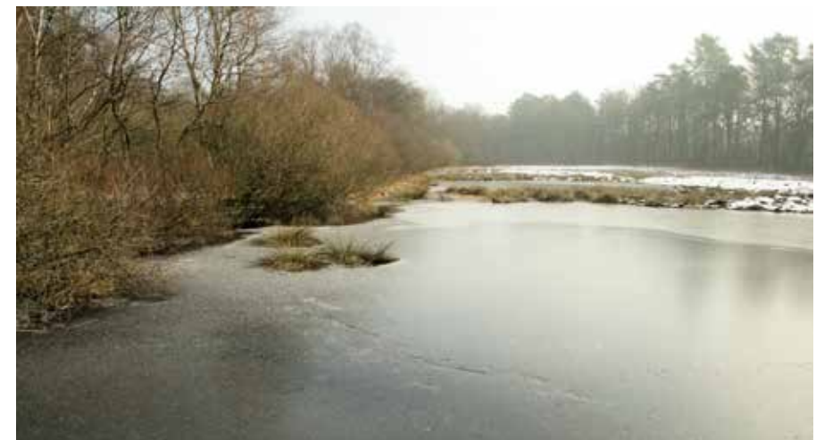
Blick von der Mitte des Damms in das Schutzgebiet hinein: Zwei der nach wenigen Tagen gefüllten Tümpel im erwünschten Zustand „kleiner Seen“
