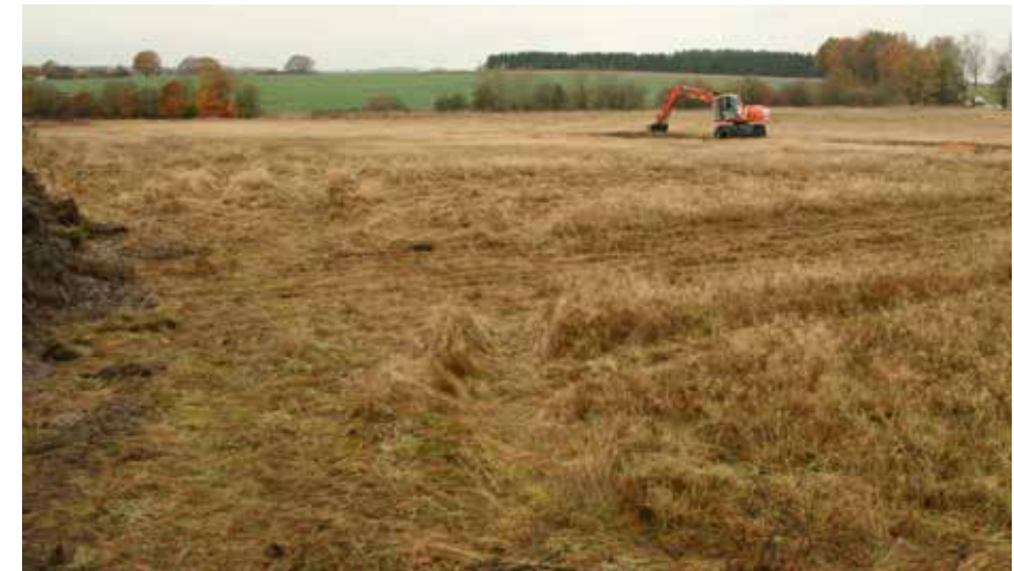
Noch fehlt selbst die kleinste Bodenwelle, aber die erste Veränderung hat gerade begonnen
