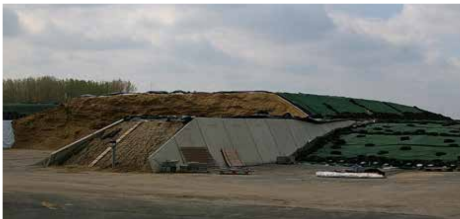
Zur Biogasanlage gehören große Siloplaten als Lagerflächen für das Gärsubstrat
