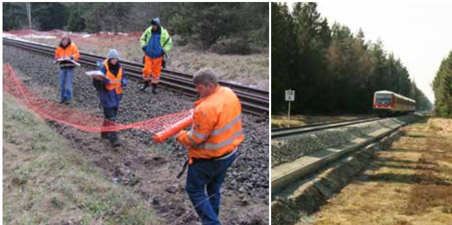
Links: Aufstellen von Biotopschutzzäunen am alten Gleisbett - Rechts: Das neue Gleisbett. Unverletzt daneben die „Flechtenmulde“ mit ihren Wuchsorten von Thymian, Mondraute u.a.
