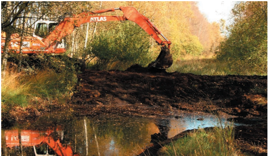
Der große Damm - unser verstärktes Bollwerk gegen das Abfließen des Wassers aus dem Moor
