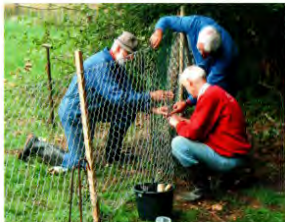
Zaunreparatur am Dössel
