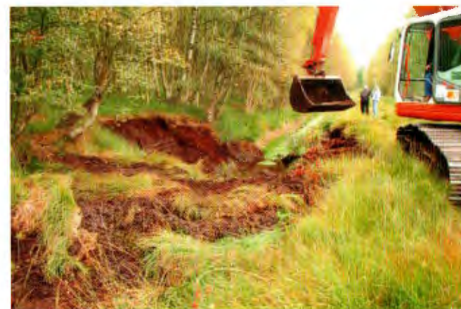
Die ersten Dämme sind gesetzt
